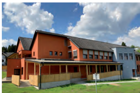
» Kinderhaus St.Ulrich/W. Umbau vor Fertigstellung
